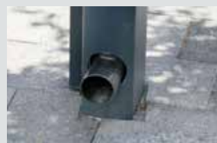
TerraLinea mit in die Stützen integrierten Fallrohr.
