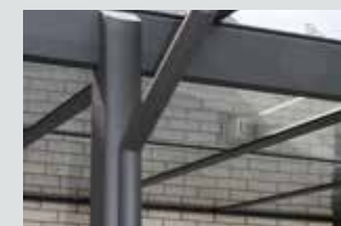
TerraMaxPlus in Dachfarbe beschichtetes Aluminiumfallrohr
