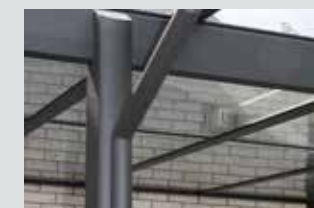
TerraFlex in Dachfarbe beschichtetes Aluminiumfallrohr
