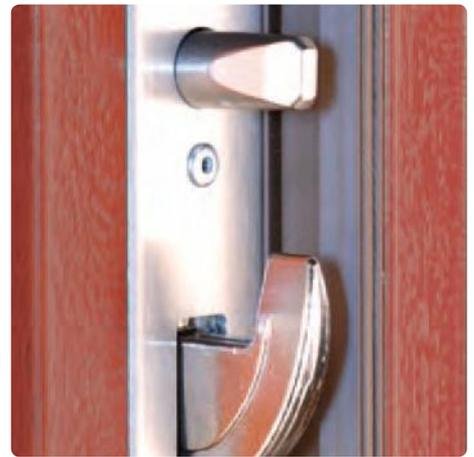
Massive Bolzen und Schwenkriegel
