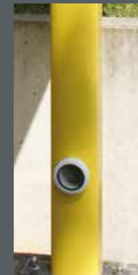
Entwässerung durch Stütze
