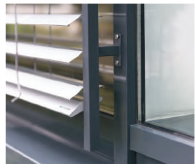
Führungsschiene mit Abstandhalter
